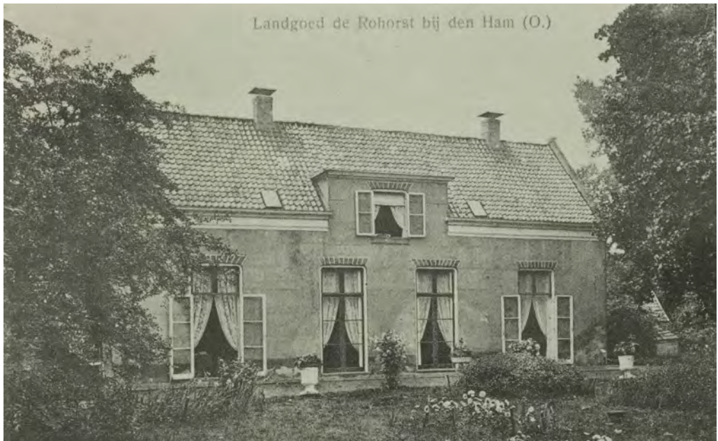
De Rohorst, hier gefotografeerd in 1916, werd in 1937 afgebroken.
